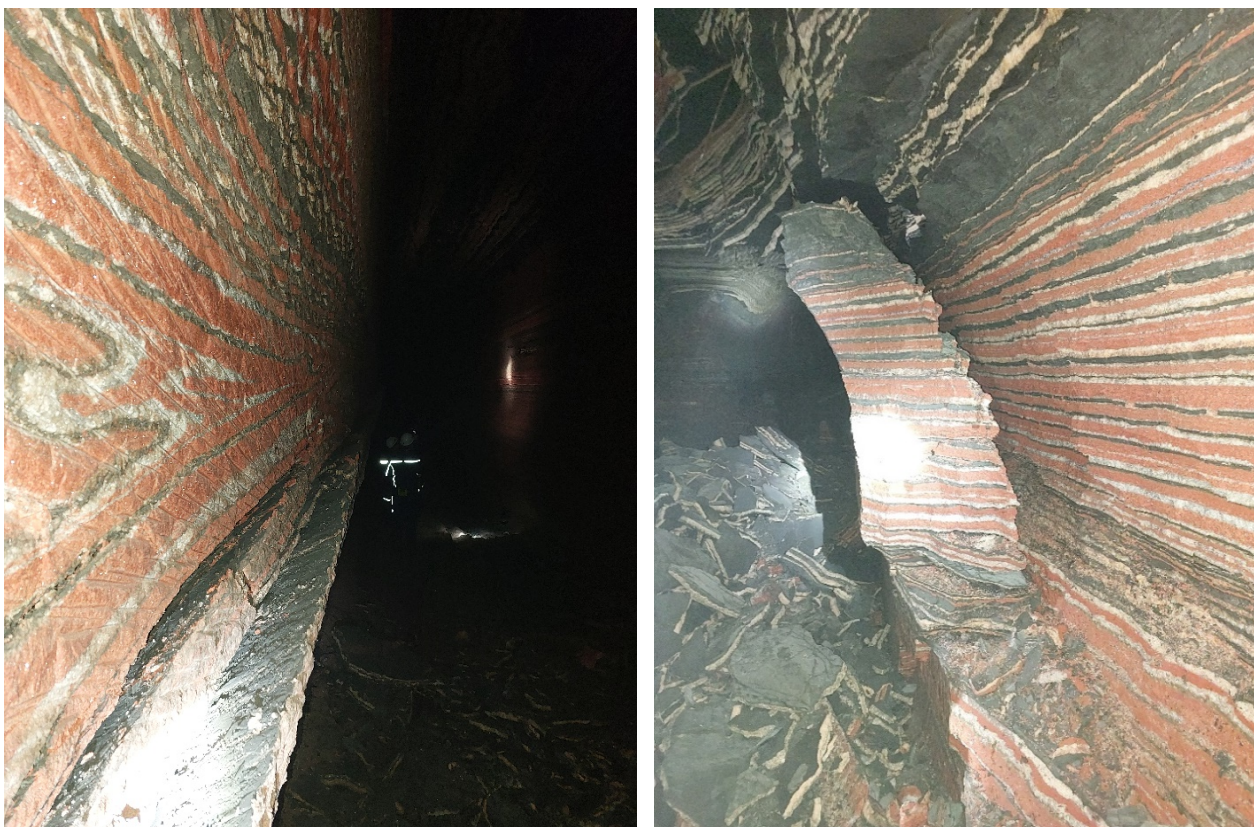
Рис. 1.6. Характер нарушенности междукамерных целиков
