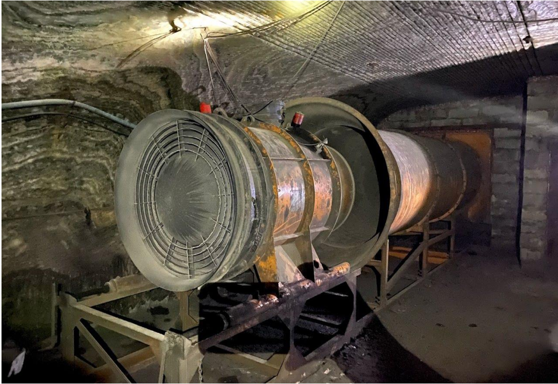
Рисунок 5.18 — Рециркуляционная система ОАО «Беларуськалий»
